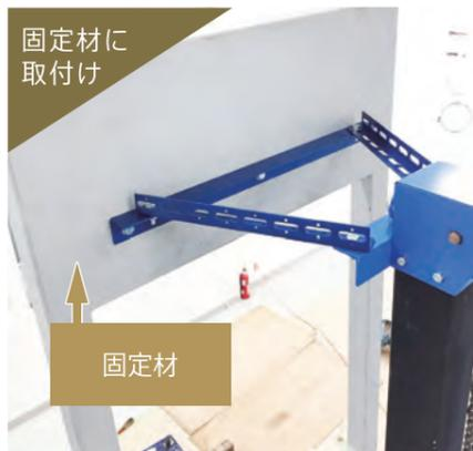
振止めは、固定材に取付けます。ブルーリフト設置にあたって、振止めの取付けは必須です。
