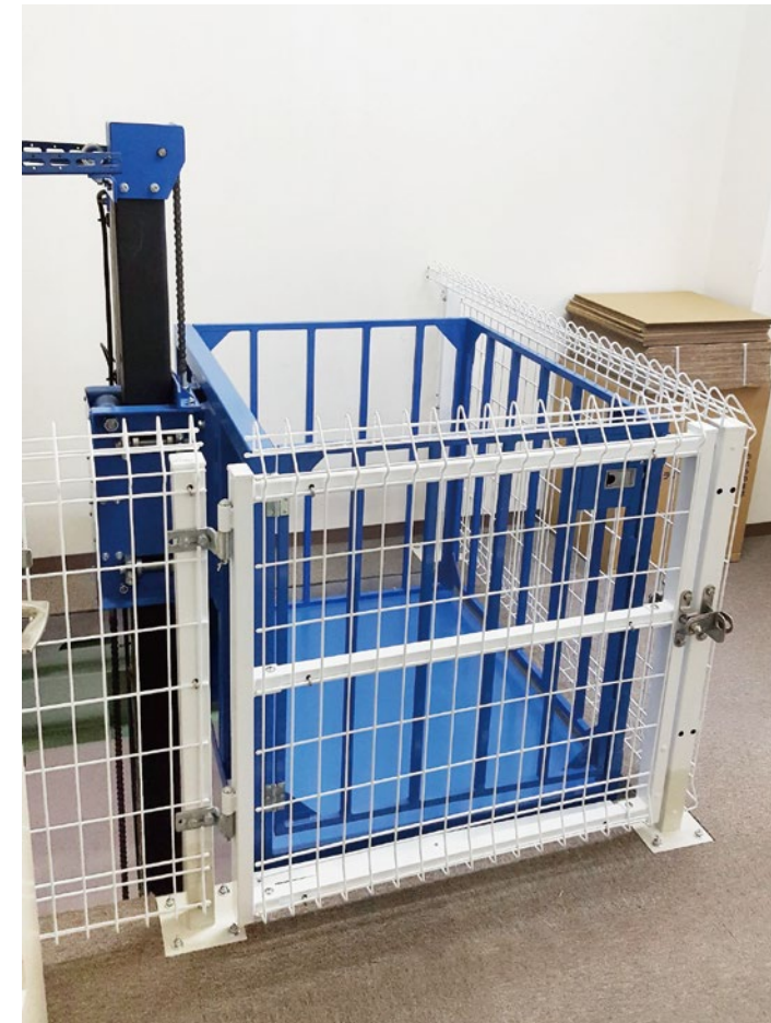
リフト周りの囲い (2階上部) ※1
