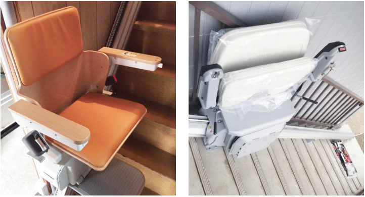
いす式階段昇降機の設置事例
