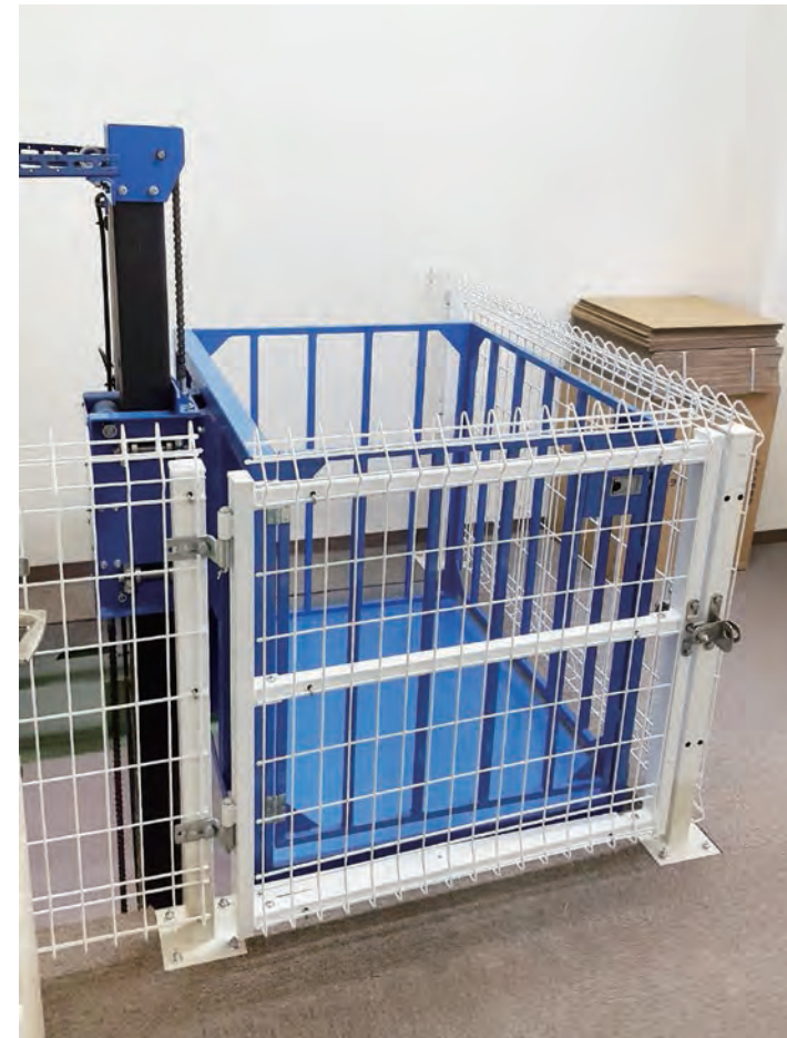
リフト周りの囲い (2階上部) ※1
