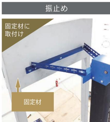
振止めは、固定材に取付けます。ブルーリフト設置にあたって、振止めの取付けは必須です。
