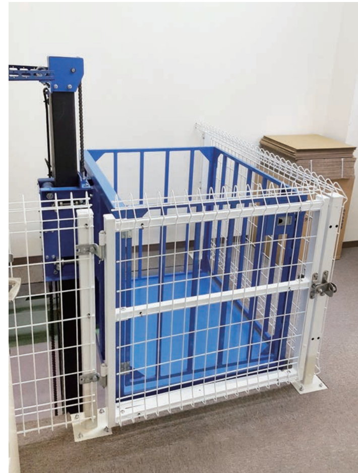
リフト周りの囲い (2階上部) ※1
