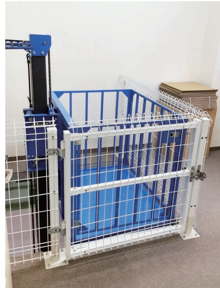
リフト周りの囲い (2階上部) ※1
